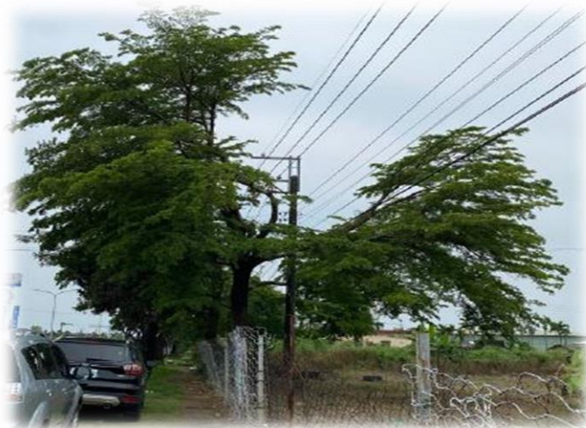
樹修不良情形
